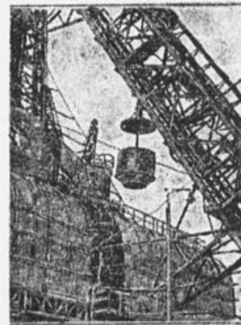
Подъемные краны в порту.
